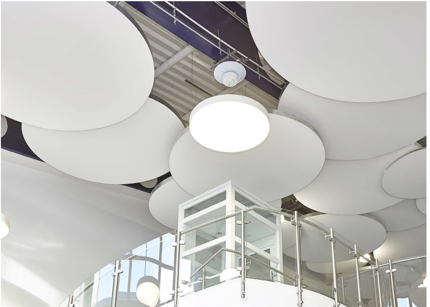
Haberdasher School, Vereinigtes Königreich. 37 Kreise mit unterschiedlichen Durchmessern: von 2,00 bis 5,00 m. Stärke: 43, 100 und 140 mm. Weiße Verkleidung und akustischer Absorber.
